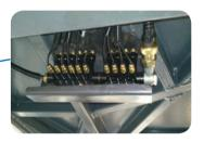
Os dispositivos de dosagem de lubrificante de linha única podem ser conectados a manifolds para ajudar na instalação fácil e com economia de espaço.
